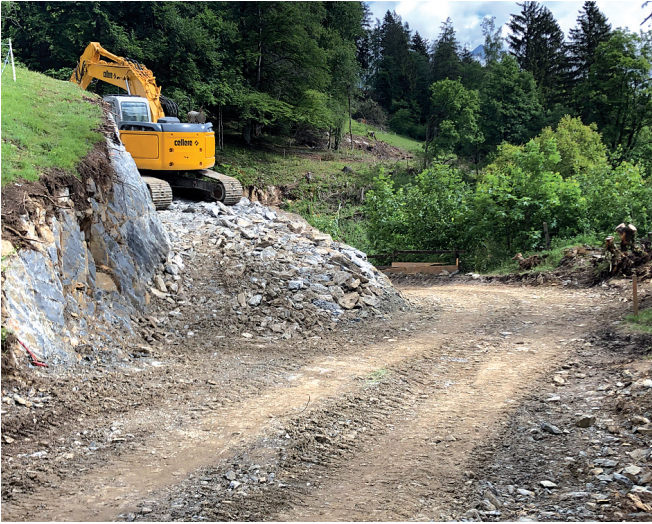
Beim Adler wird das abgetragene Material Strassenverbreiterung aufgeschüttet.
