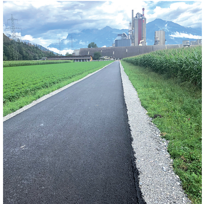
Der sanierte Güterweg im «Wingertli».
